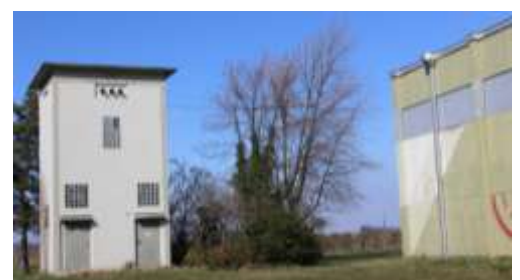
Übergabestation neben der VG- Sporthalle
